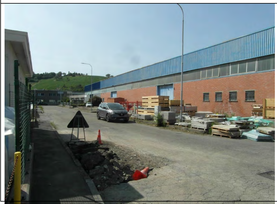
FOTO 1 - VISTA STAZIONE RADIO BASE
