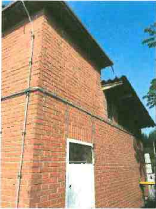
Aperture da chiudere sulla porta del vecchio locale caldaia non più utilizzato
