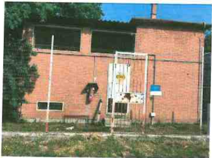
Fronte cabina di riduzione gas metano
