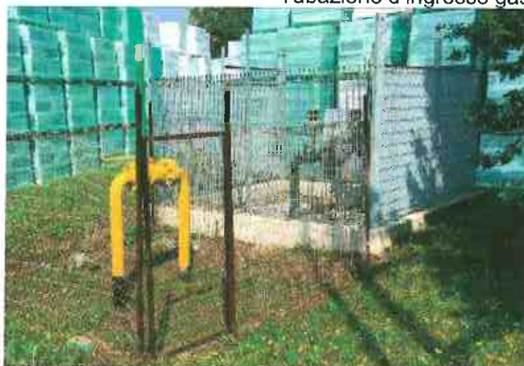
Valvola gen. su tubazione di arrivo da SNAM
