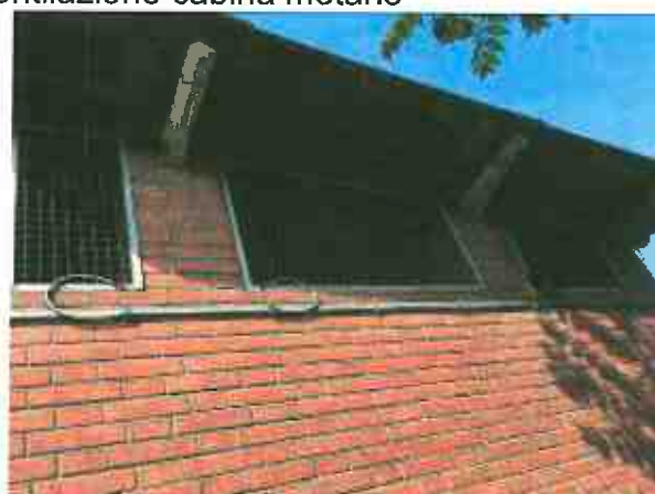
Aperture di ventilazione cabina metano
